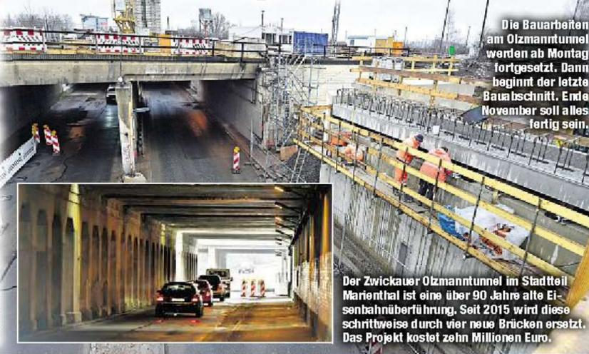
Der Zwickauer Olzmannntunnel im Stadtteil Marienthal ist eine über 90 Jahre alte Eisenbahnüberführung. Seit 2015 wird diese schrittweise durch vier neue Brücken ersetzt. Das Projekt kostet zehn Millionen Euro.
