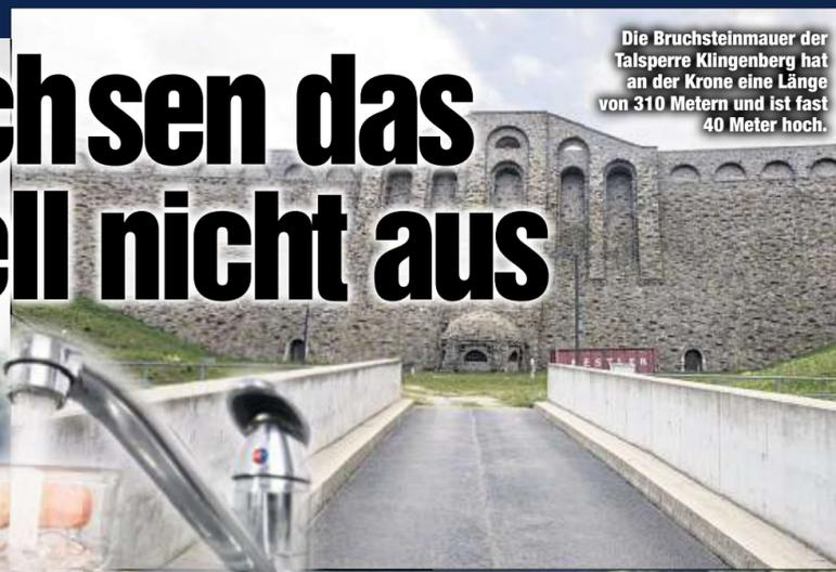
Die Bruchsteinmauer der Talsperre Klingenberg hat an der Krone eine Länge von 310 Metern und ist fast 40 Meter hoch.
