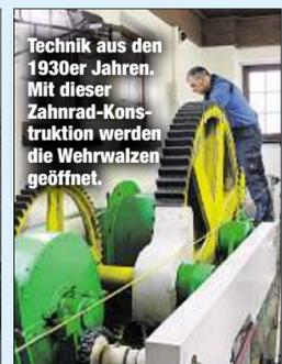
Technik aus den 1930er Jahren. Mit dieser Zahnrad-Konstruktion werden die Wehrwalzen geöffnet.
