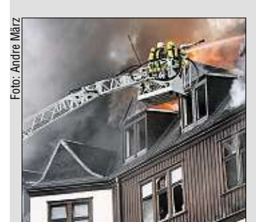
Die Feuerwehr musste in Schwarzenberg im ehemaligen Ida-Heim ein Feuer löschen.
