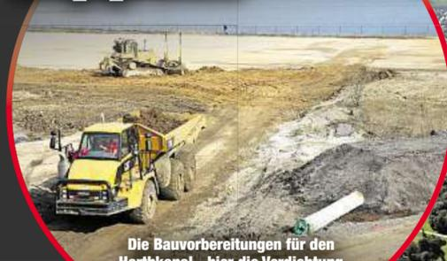
Die Bauvorbereitungen für den Harthkanal - hier die Verdichtung des Baugrundes - haben bereits begonnen.
