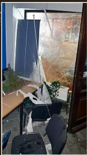
Der Böller zerstörte die Fensterscheibe und das Büro der Partei.
