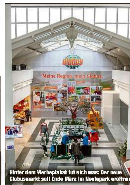
Der Innenausbau des neuen Globus-Lebensmittelmarktes läuft auf Hochtouren.
