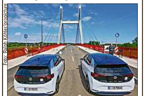
Freie Fahrt über die neue Muldenbrücke in Schlunzig.
