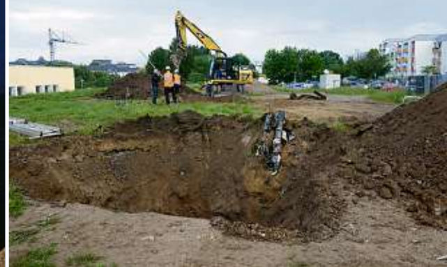
Das Wasserrohr aus Vorkriegszeiten war in keinem offiziellen Plan verzeichnet.
