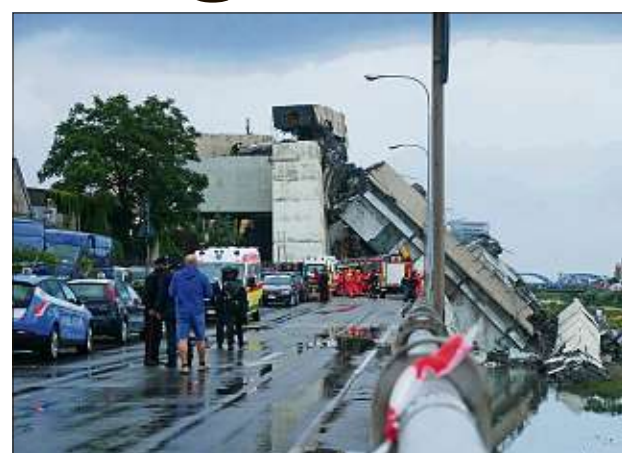
Vor zwei Jahren stürzte die alte Morandi-Brücke in sich zusammen und riss 43 Menschen mit in den Tod.
