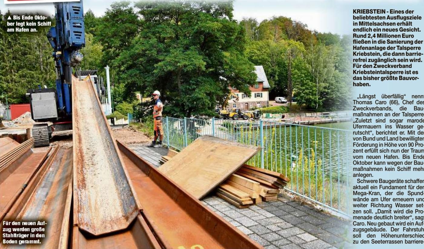
Für den neuen Aufzug werden große Stahlträger in den Boden gerammt.
