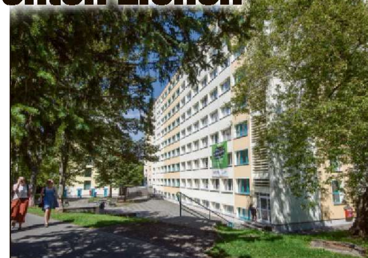
Das Wohnheim Vetttersstraße 66 ist fertig saniert.
