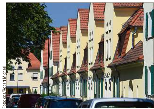
Die Bergarbeitersiedlung „Erika“ in Lauta entstand 1918 im Zuge der Gründung der Aluminiumhütte. Nun soll sie eine Verjüngungskur erhalten.
