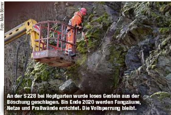
An der S 228 bei Hopfgarten wurde loses Gestein aus der Böschung geschlagen. Bis Ende 2020 werden Fangzäune, Netze und Prallwände errichtet. Die Vollsperrung bleibt.
