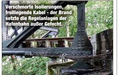
Verschmorte Isolierungen, freiliegende Kabel - der Brand setzte die Regelanlagen der Hafeneisenbahn außer Gefecht.
