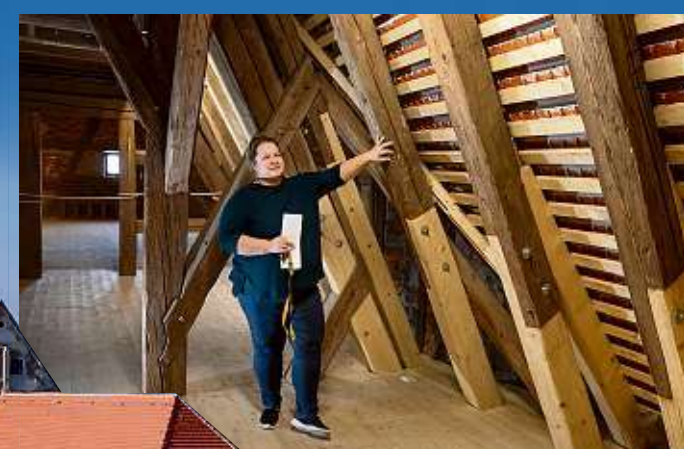
Burgleiterin Susann Lentzsch prüft das sanierte Dach.
