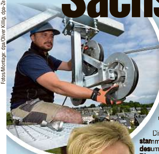
Auch in Altenberg entsteht dieser Tage ein neuer Skilift. Hier Monteur Marek Kedzier (42) bei der Arbeit.
