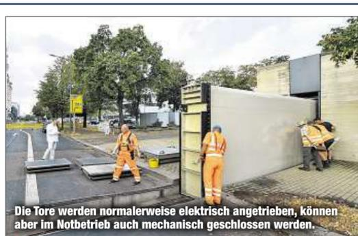
Die Tore werden normalerweise elektrisch angetrieben, können aber im Notbetrieb auch mechanisch geschlossen werden.
