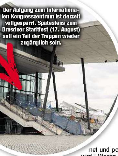
Der Aufgang zum Internationalen Kongresszentrum ist derzeit vollgesperrt. Spätestens zum Dresdner Stadtfest (17. August) soll ein Teil der Treppen wieder zugänglich sein. net und porös wird.“ Wegen der enormen Hitze könnten sich die Bauarbeiten dadurch aber um zwei Wochen verzögern. Das ist aber noch nicht alles: Bis Mitte November bekommt die Treppe elbseitig ein zusätzliches Geländer. Damit Regenwasser wieder ungehindert ablaufen kann, werden außerdem die Entwässerungsröhre gefräst. Und auch die Treppenheizung wird erneuert. Da kann der Winterja kommen...! sey
