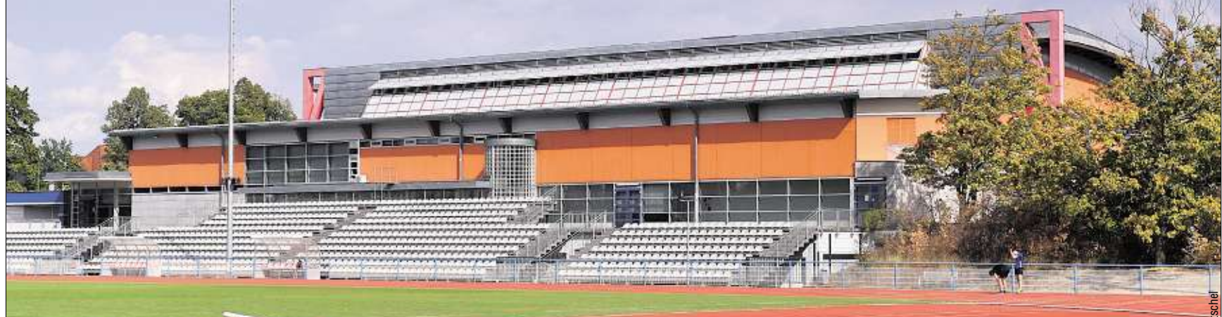
Vor zwanzig Jahren wurde die Margon Arena eingeweiht. Seit Jahren ist das Dach undicht, jetzt droht der GAU mit der Hallen-Sperrung.
