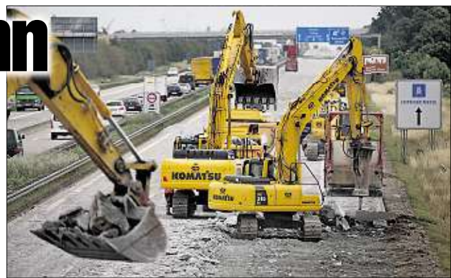
An der A14 bei Schkeuditz wird seit Jahren gebaut.
