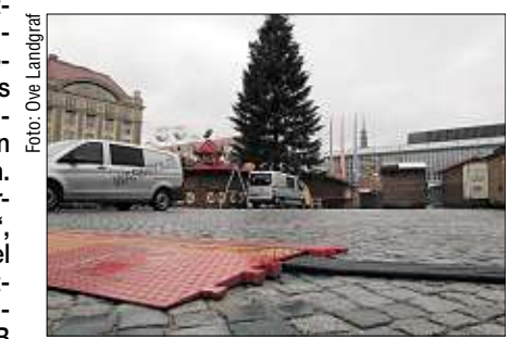
Die Altmarkt-Sanierung steht auf der Kippe. Unter anderem sollten die Kabel (F) im Boden verschwinden.
