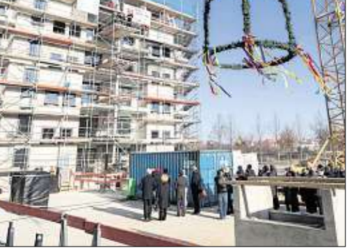
Die ersten 179 Wohnungen sollen im Sommer 2019 fertig sein.
