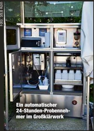
Ein automatischer 24-Stunden-Probennehmer im Großklärwerk
