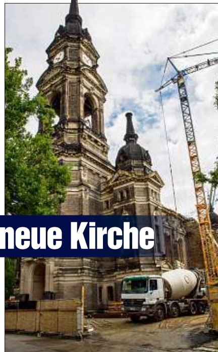
Mittels Riesenpumpe wurden die rund 120 Kubikmeter Beton über die Mauern der Trinitatiskirche hinweg an ihren Bestimmungsort gebracht.
