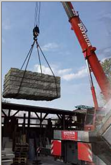
▲ Der 13 Tonnen schwere Sandstein-Block wurde via Kran abgeladen.
