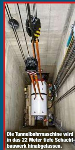
Die Tunnelbohrmaschine wird in das 22 Meter tiefe Schachtbauwerk hinabgelassen.
