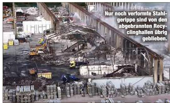
Nur noch verformte Stahlgewölbe sind von den abgebrannten Recyclinghallen übrig geblieben.
