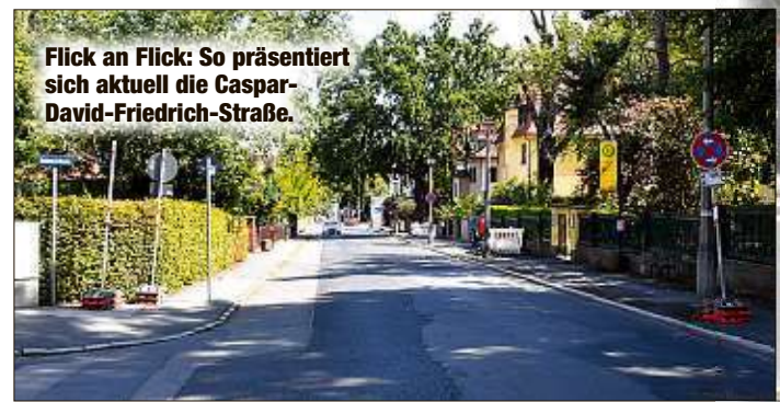
Erste Straßenschilder weisen bereits auf die Sanierung hin.
