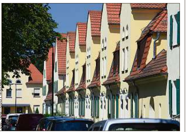
Die Bergarbeitersiedlung „Erika“ in Lautas entstand 1918 im Zuge der Gründung der Aluminiumhütte. Nun soll sie eine Verjüngungskur erhalten.
