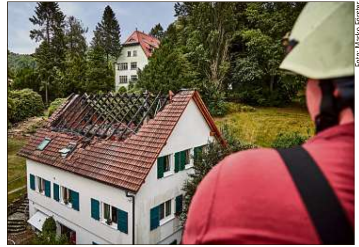
Der Dachstuhl des Hauses in Bad Gottleuba wurde durch das Feuer komplett zerstört.
