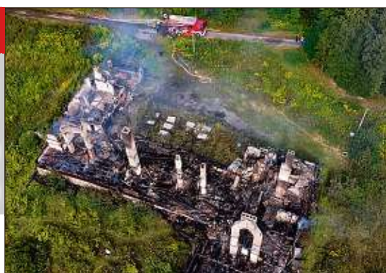
Die Nachlöscharbeiten am Ferienheim zogen sich bis Montagabend hin. Unter den Holzhäufen lauert Glutnester.
