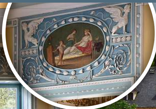
Experten reinigten Schnitz- und Stuckarbeiten sowie Malereien, ergänzten fehlende Teile.
