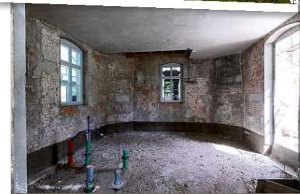
Innen wurde bereits entkernt, der Neuaufbau läuft.
