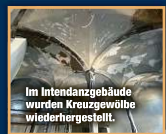
Im Intendantengebäude wurden Kreuzgewölbe wiederhergestellt.
