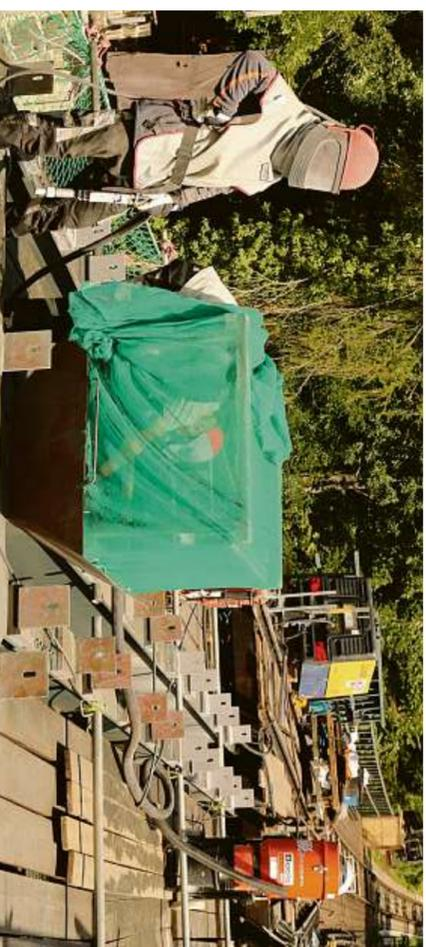
Was hier aussieht wie eine Figur aus den Star-Wars-Filmen, ist in Wirklichkeit ein Mitarbeiter der Firma Fuchs, der das Viadukt mit Sandstrahlverfahren zur Aufnahme der neuen Traggeländer für die Schienen vorbereitet.
