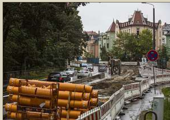
Die DVB verlegen auf der Bautzner Straße neue Gleise, damit zukünftig die breiteren Bahnen fahren können.
