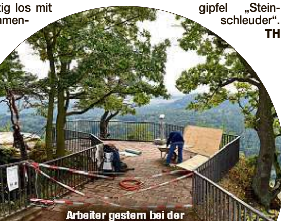
Arbeiter gestern bei der Sicherung des Felsvorsprungs an der Bastei. Deutlich zu sehen: der abgesperrte Teil.
